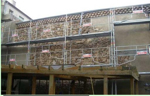
**Bâtiment :** réfection de la façade EST du Temple de la Bâtie fissurée et écaillée. Le nouveau crépi assainira le mur qui risquait de se dégrader rapidement par les infiltrations des eaux pluviales. Travaux réalisés par l'entreprise BATHAIL pour un montant TTC de 5400 € pris en charge sur le budget communal.
