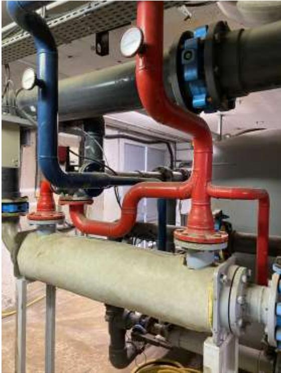
La machinerie de l'établissement construit en 1969 a été remise à neuf : Restauration des filtres à sable, changement de l'armoire électrique qui commande les différentes installations techniques de la piscine, nouvelles pompes pour le recyclage de l'eau des bassins, avec deux objectifs : assurer un meilleur traitement de l'eau et éviter les fuites, entraînant par la même occasion des économies d'eau.
