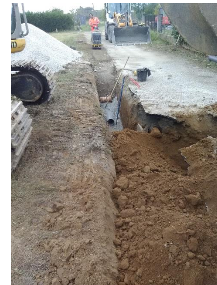
Réfection de plus de 1 000 m linéaires de réseau
