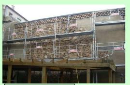
Bâtiment: réfection de la façade EST du Temple de la Bâtie fissurée et écaillée. Le nouveau crépi assainira le mur qui risquait de se dégrader rapidement par les infiltrations des eaux pluviales. Travaux réalisés par l'entreprise BATHAIL pour un montant TTC de 5400 €pris en charge sur le budget communal.
