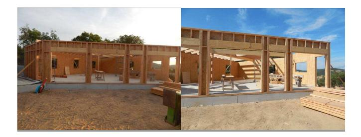
Les travaux se déroulent conformément au planning prévisionnel et l'ossature bois d'une des villas est quasiment achevée.
